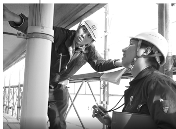
質の高い改修工事の様子
